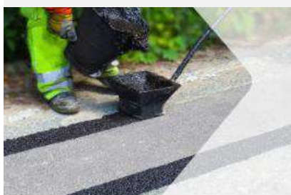
Repararea & Reabilitarea Drumurilor
