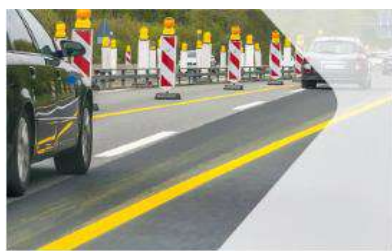
Marcaje în zonele de construcții
